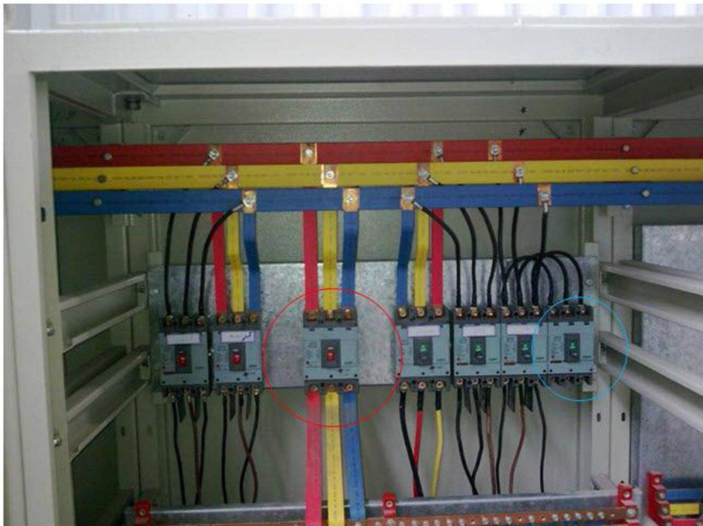
سه فاز از طریق یک کلید MCCB وارد قسمت بعدی که شینه های سوراخ دار هستند می شود. شینه های سوراخ دار توسط مقره های پلکانی به بدنه تابلو محکم می شوند. دلیل این امر هم این است که با استفاده از این مقره ها شینه ها در سه ارتفاع مختلف نسبت به هم قرار گرفته و سیم کشی آنها راحتتر انجام می شود.
